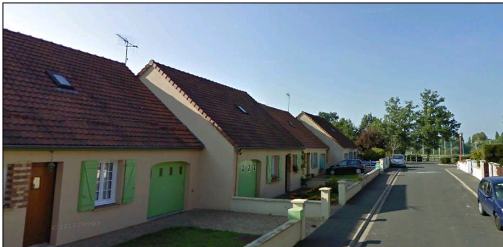
Un système répété de doubles trottoirs, des maisons parfois mitoyennes, en retrait de la voie.
