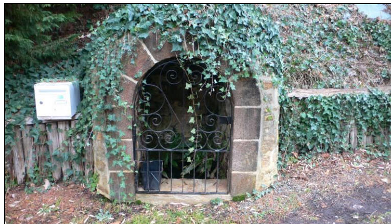
Fontaine chemin du Moulin
