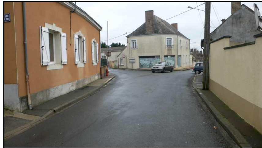
Certains espaces resserrés, dangereux pour les piétons et cycles
