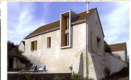
Grange en Indre et Loire archi. Belus Henocq
