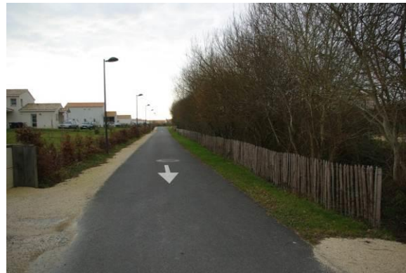
Voie partagée – Quartier Vauban à Fribourg En Breisgau
