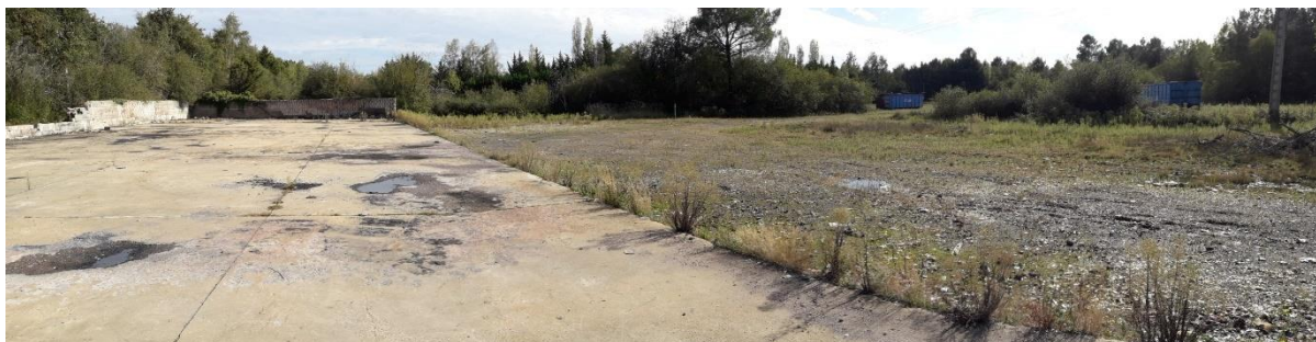
Photo. 7 : vue d'ensemble du sud de la partie sud de la ZIP (O-GEO, 09/04/2020)
